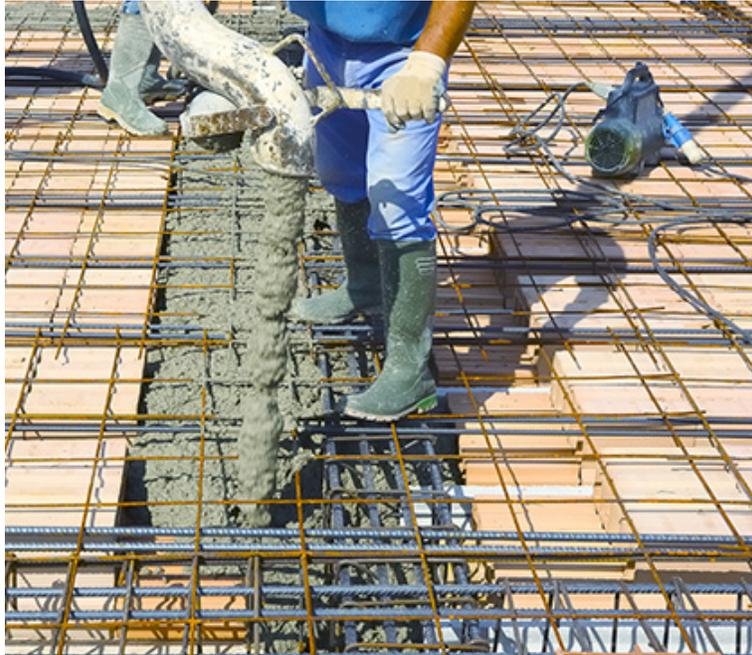
建造如此高的商用建筑，需要最佳的高效减水剂，因为需要将所有混凝土泵送至 80 层，离地约 259 米高。鉴于钢筋的相互作用，在不同楼层，混凝土还须符合 160 毫米至 200 毫米的坍落度范围要求。
